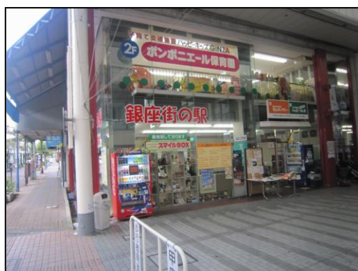
【銀座街の駅の外観】
